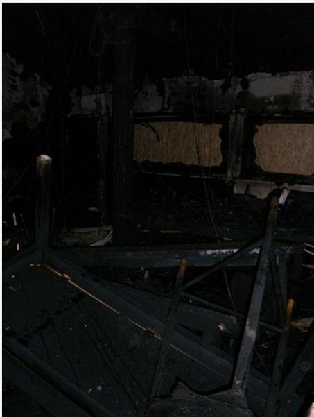
Die komplette Inneneinrichtung ist zerstört, der Baukörper massiv geschädigt, inwieweit Teile später noch nutzbar sind ist derzeit Gegenstand der Untersuchungen.
