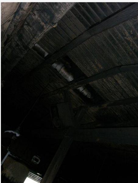
Im vorderen Bereich des Sportheims. Teile der Holzdecke haben sich gelöst. Am Firstbereich ist die Lüftungsrohr das zum hinteren Sportheimbereich führt zu erkennen.
