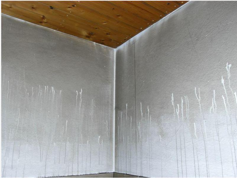
Rauch und Löschwasser haben dem Sanitärgebäude massiv zugesetzt.
