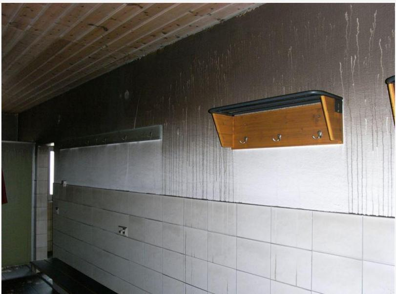
Die Umkleidekabine, durch Löschwasser und Rauchentwicklung schwer beschädigt ebenso...
